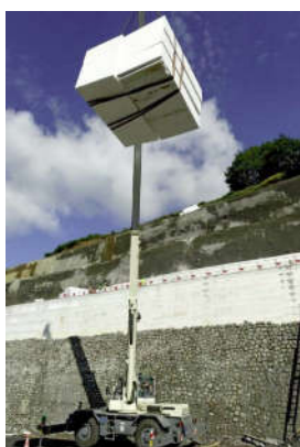
Geofoam trong xây dựng cầu đường
